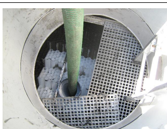
Figure 3 : Extraction des boues avec le dispositif ASPIBOU®
